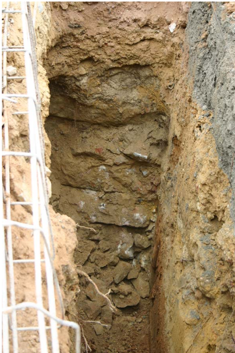
Detall de l'estructura de contenció de terres apareguda a la rasa per les pantalles de protecció del refugi 307
