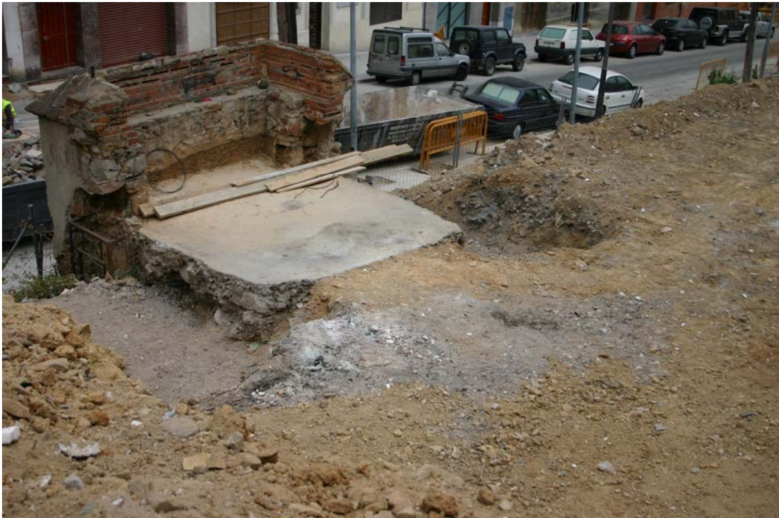
Vista de la part superior de l'accés al refugi 307 al carrer Nou de la Rambla.
