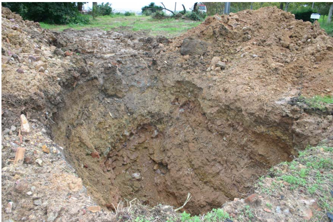
Imatge de la rasa 3, situada a la part central del solar.
