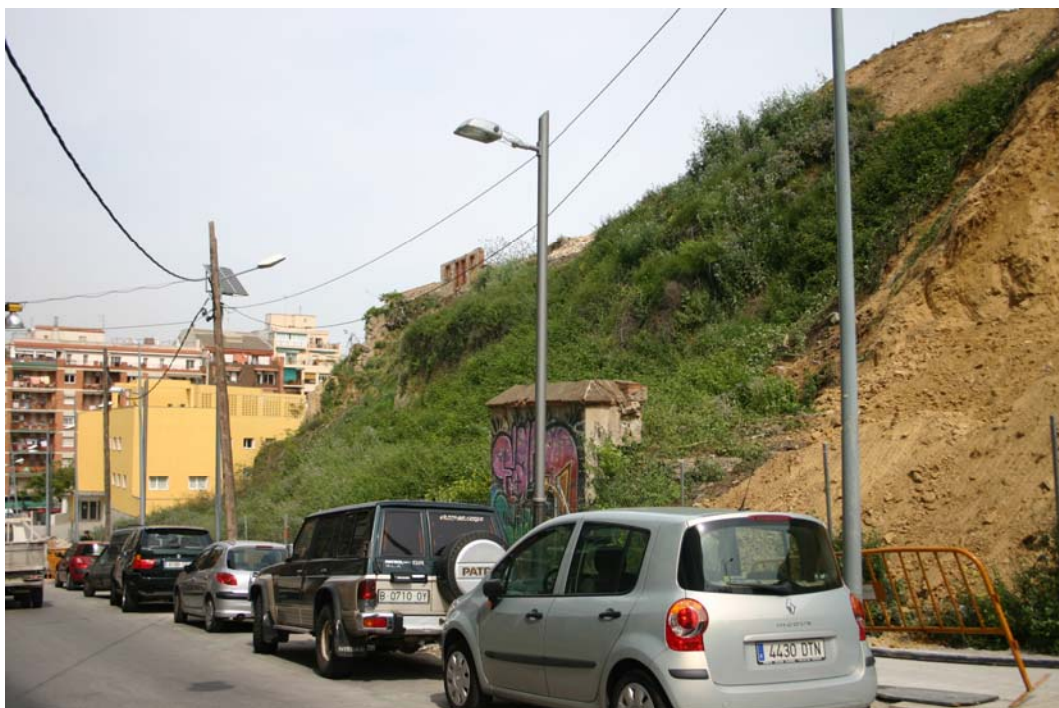
Vista de la zona del carrer Nou de la Rambla on es situa l'accés al refugi 307, amb l'estructura de formigó exterior.
