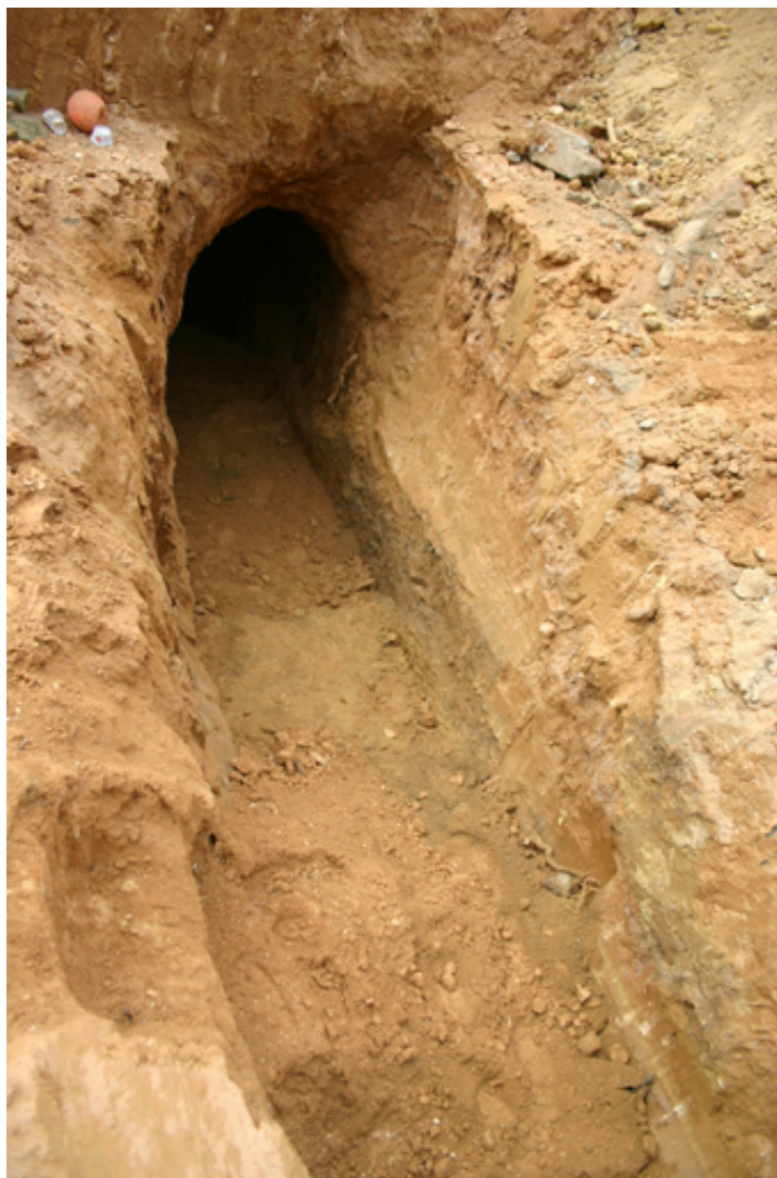
Corredor sud d'accés.
